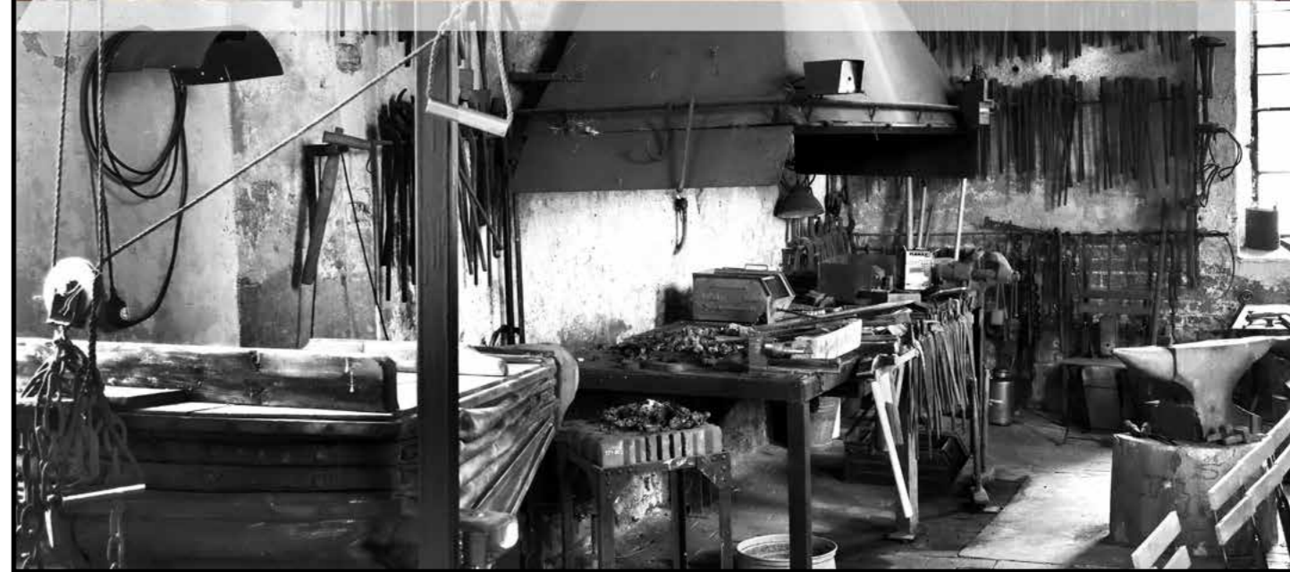
Brikettfabrik „Herrmannschacht“ in Zeitz
