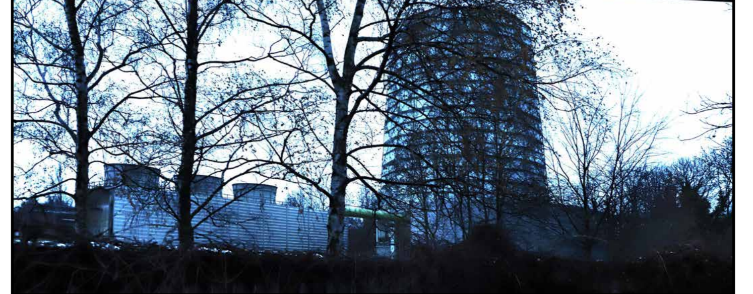
Heruntergefahrenes MIBRAG-Kraftwerk Deuben
