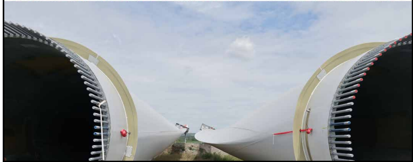
Aufbau von Windkraftanlagen bei Amsdorf
