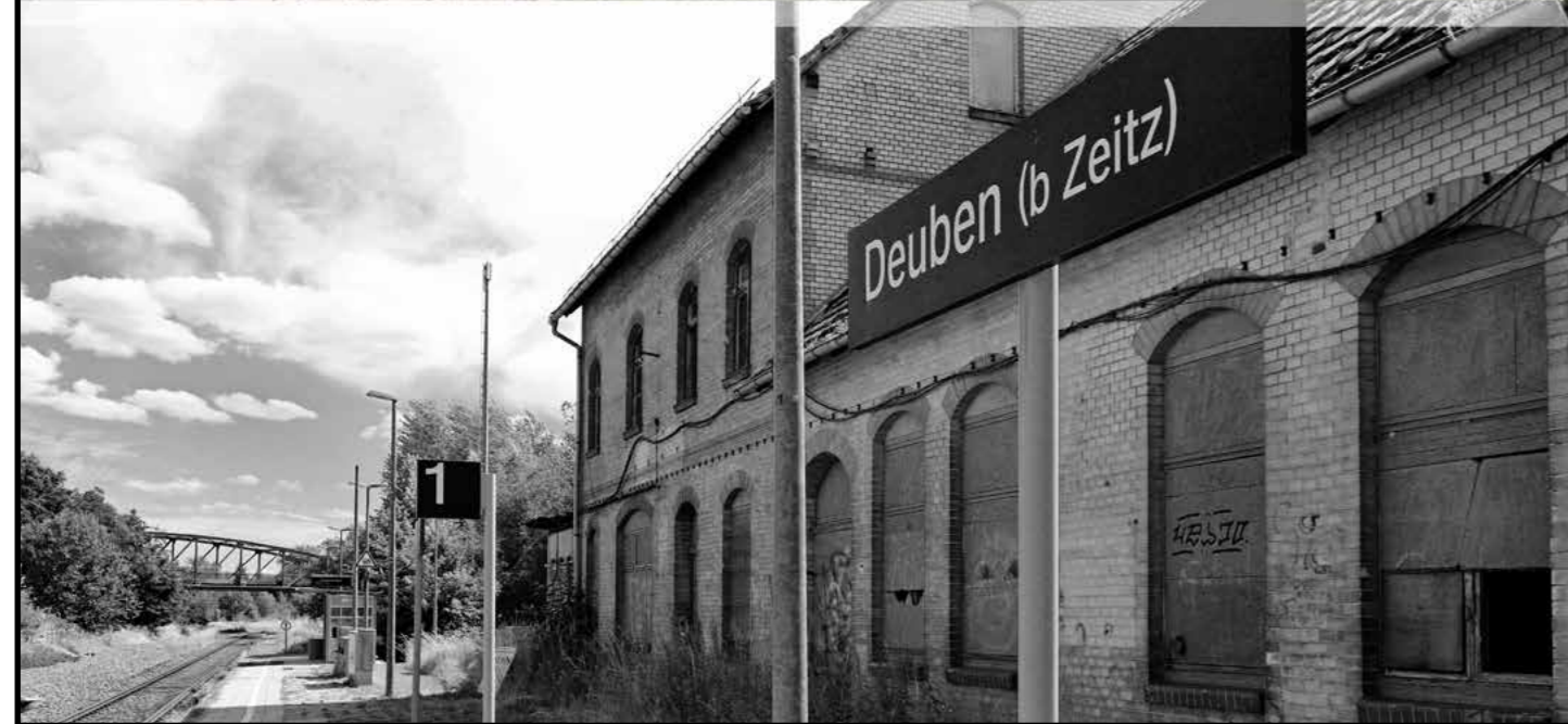
Heruntergefahrenes MIBRAG-Kraftwerk Deuben und Bahnhof Deuben
